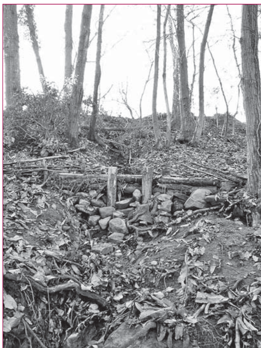
▲ Photo 1 – Exemple d'aménagement de ravines court-circuitant une bande boisée (Chambre d'agriculture du Rhône Beaujolais, maison familiale d'Anse).
